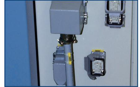
Steckverbindung zum Anschluss einer Prozessdatenerfassung
